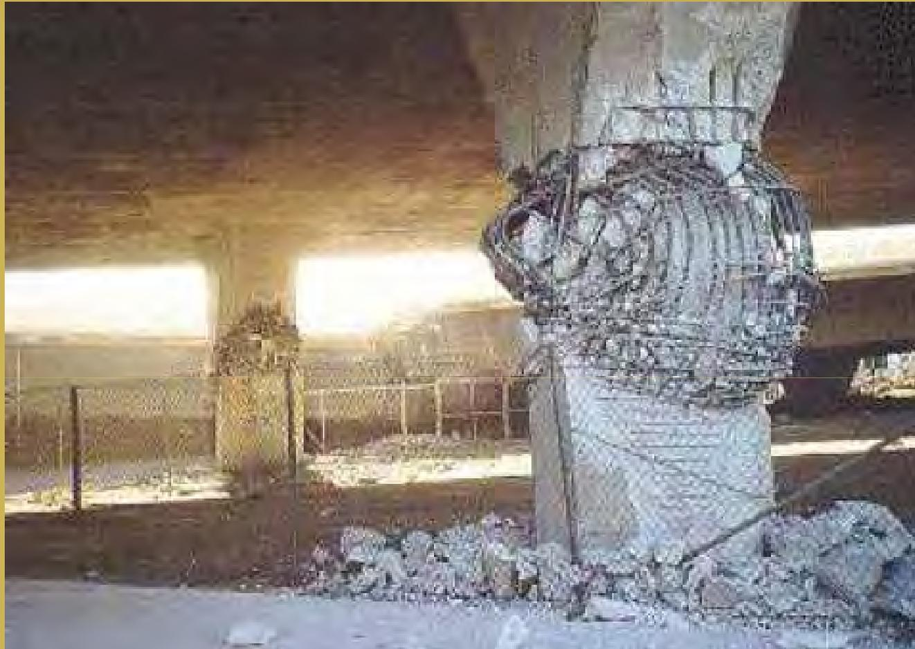
**Poteau Porteur en rupture en raison de surcharge inadmissible**
